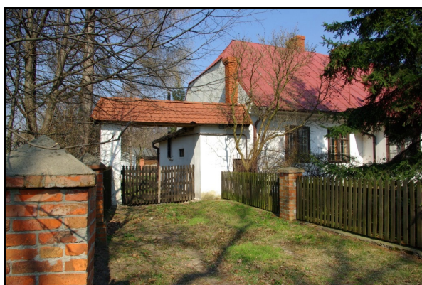
Fot.77-78. Budynek plebanii
