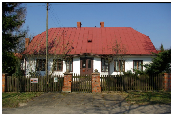
Fot.75-76. Budynek plebanii
