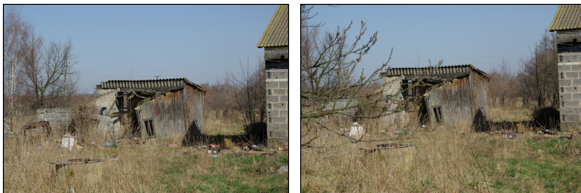
Fot.83-84. Pozostałość po chlewie z zagrodzie nr 20 w Starych Budach Radziejowickich
