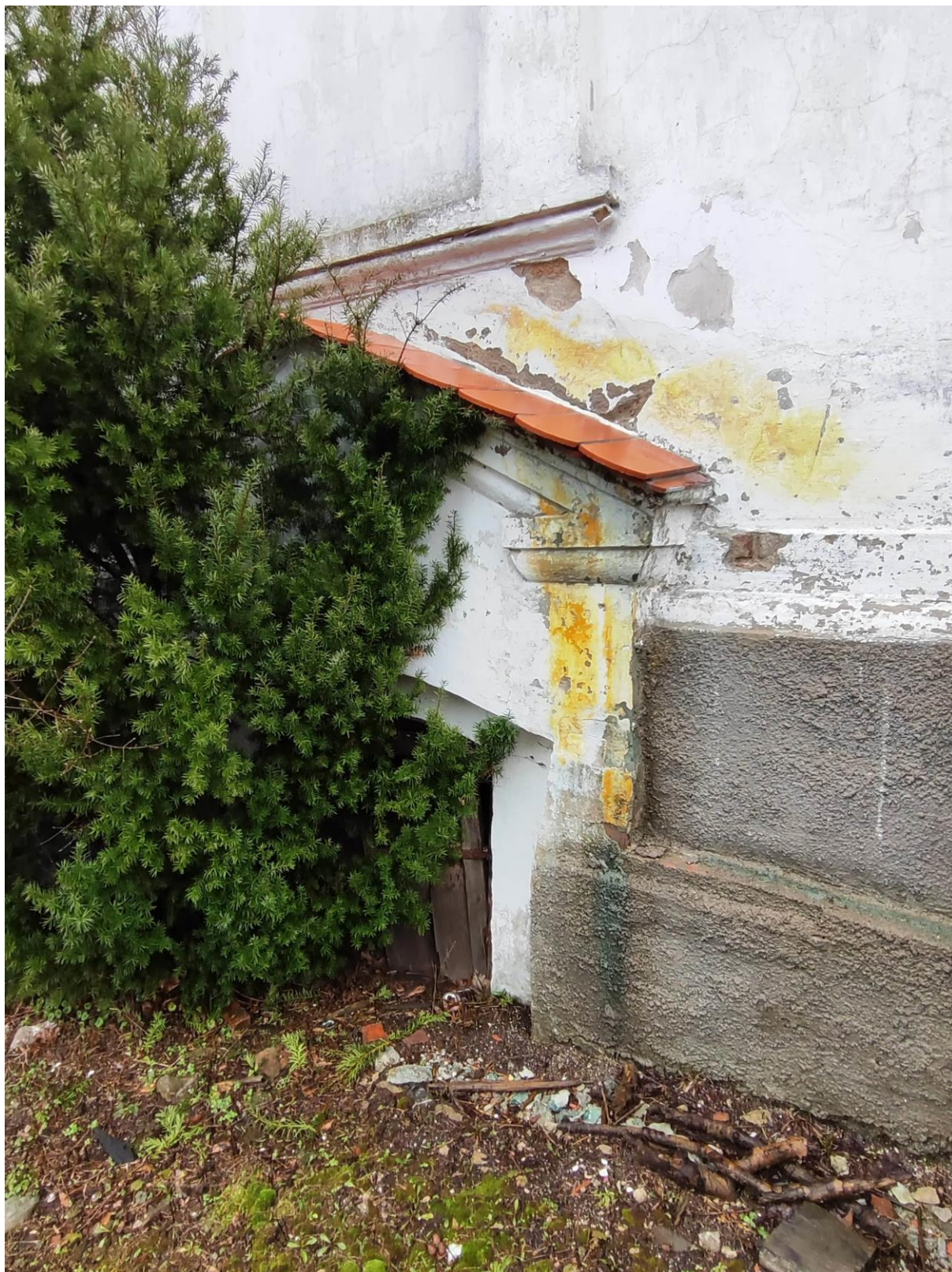
Elewacja zachodnia dzwonnicy – zniszczone drzwi deskowe, wtórne pokrycie gzymsu dachówką.
