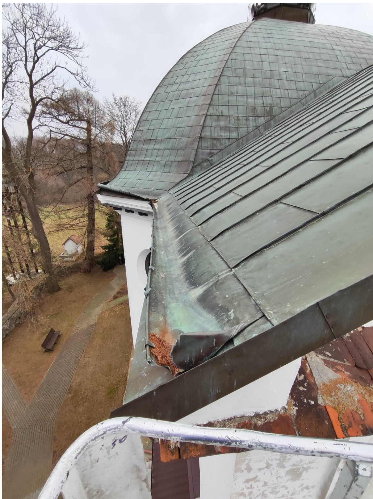
Zachodni fragment dachu – zniszczona rynna leżąca.
