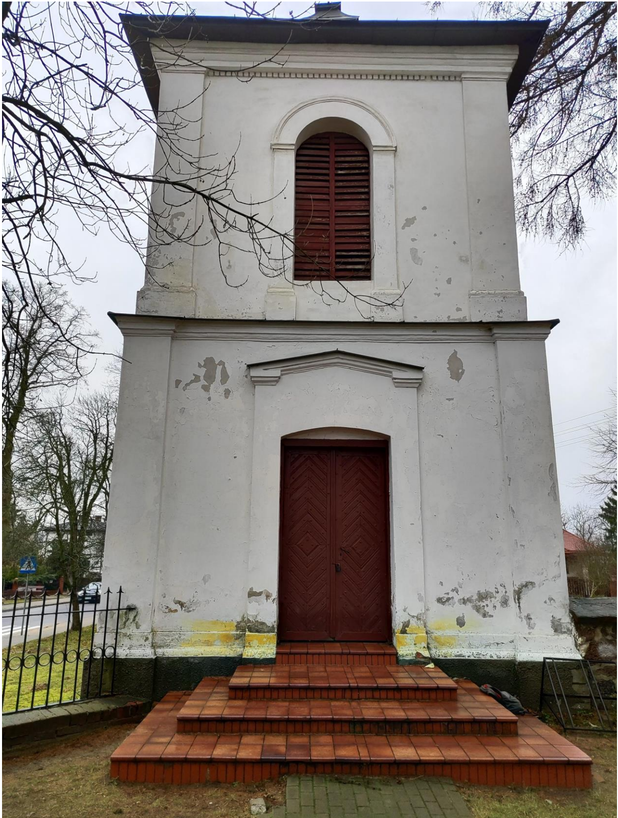
Elewacja wschodnia dzwonnicy – wtórne pokrycie schodów, widoczne kapilarne podciąganie wilgoci, zniszczona żaluzja drewniana.
