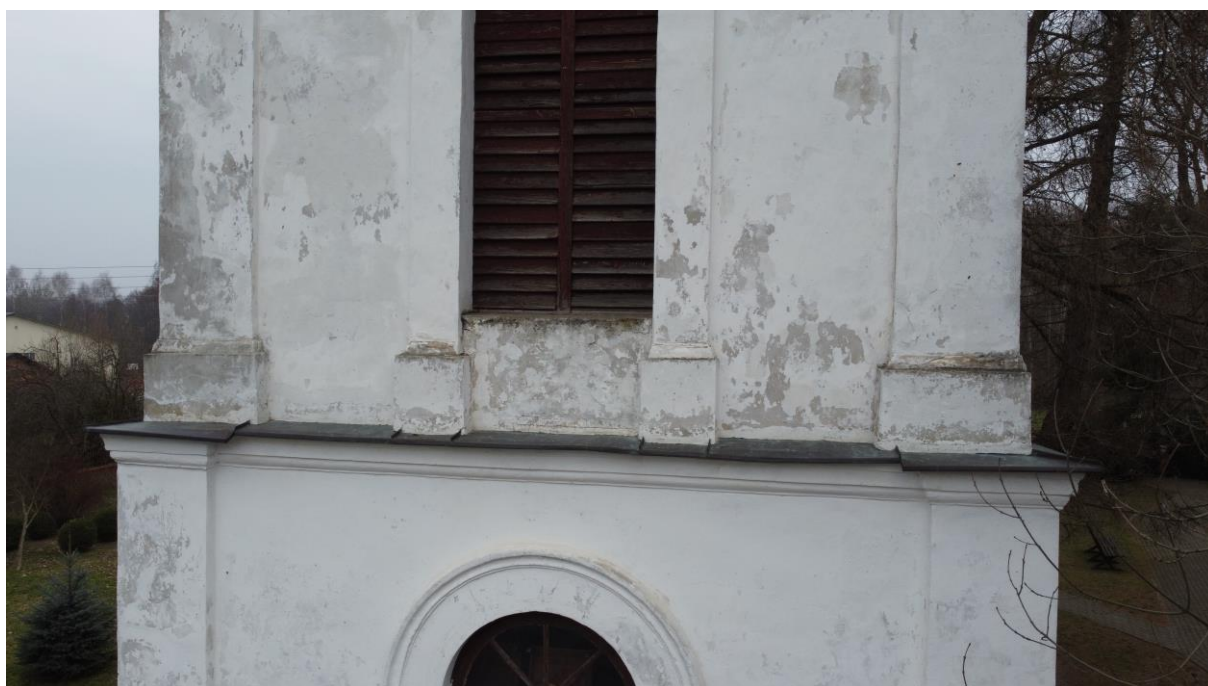
Elewacja południowa dzwonnicy – zniszczona żaluzja, brak obróbki parapetowej pod żaluzją.
