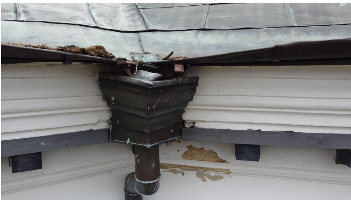
Zbyt mały kosz kończący rurę spustową, zniszczona rynna leżąca.
