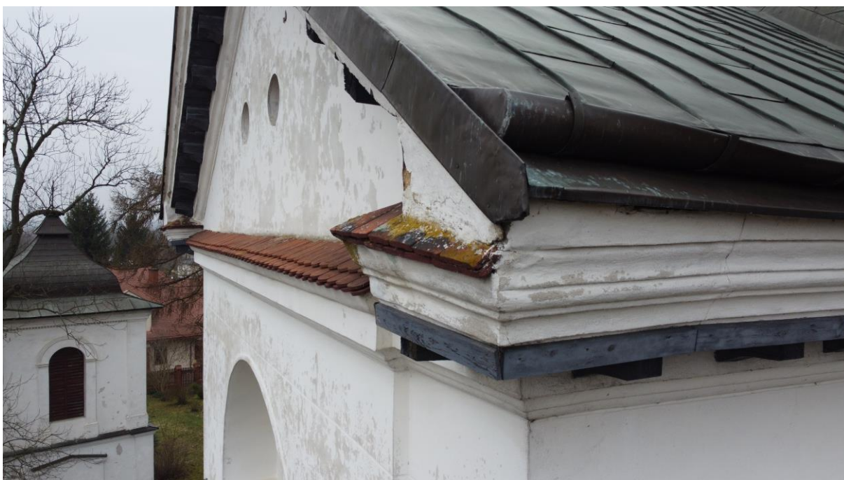
Narożnik południowo-wschodni – pęknięcie konstrukcyjne narożnika, wtórna dachówka na gzymsie południowym.
