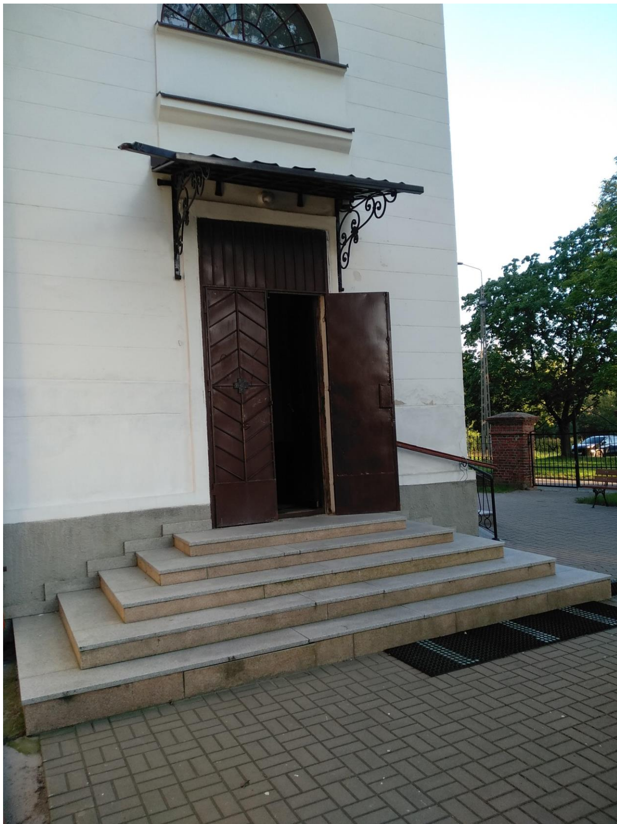
Elewacja zachodnia – wtórna okładzina schodów, daszek pokryty współczesną blachą dachówkową.
