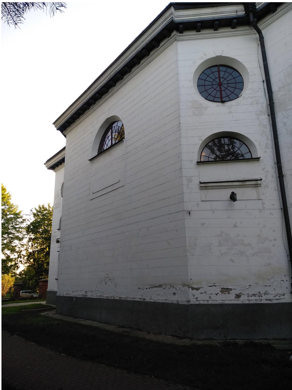
Elewacja wschodnia – widoczna granica kapilarnego podciągania wilgoci, szczelna opaska.
