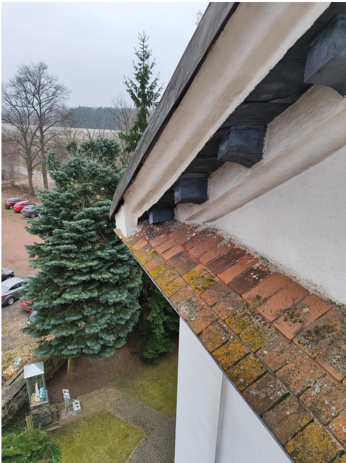
Elewacja północna – gzyms wieńczący szczyt na konstrukcji drewnianej, pokrycie gzymsu oryginalną dachówką.
