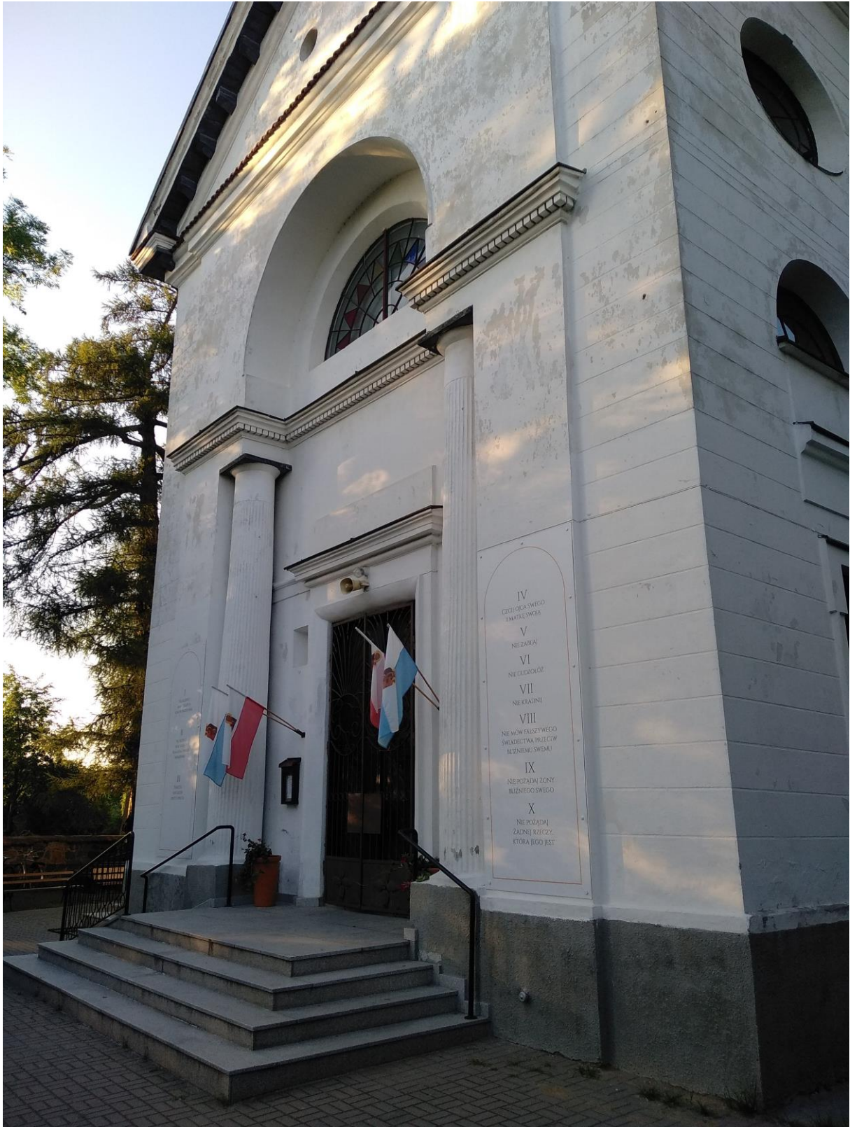
Elewacja południowa – szczelny tynk cokołowy, wtórne pokrycie schodów..
